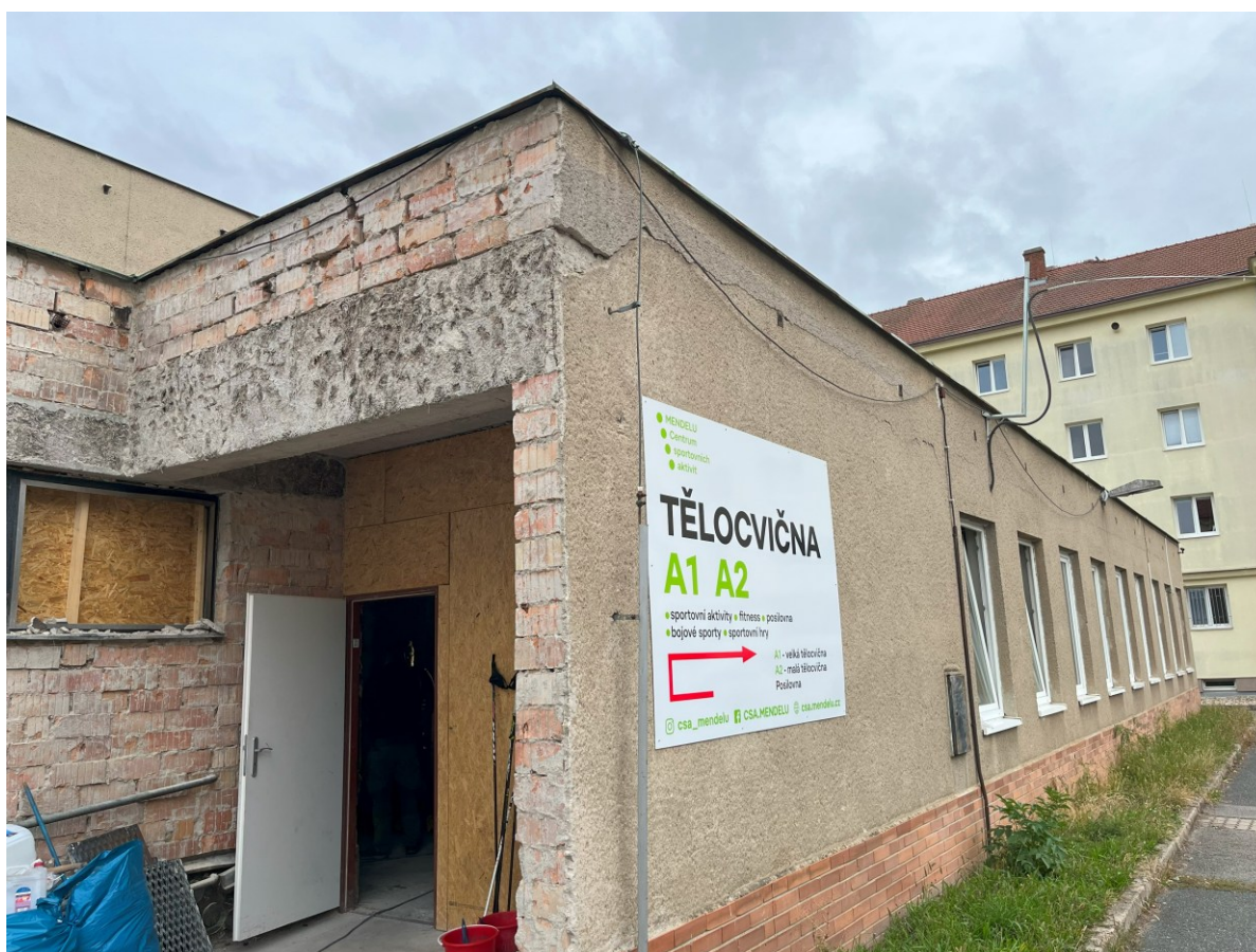
Obr. 4 Pohled na poškozenou atiku ploché střechy
