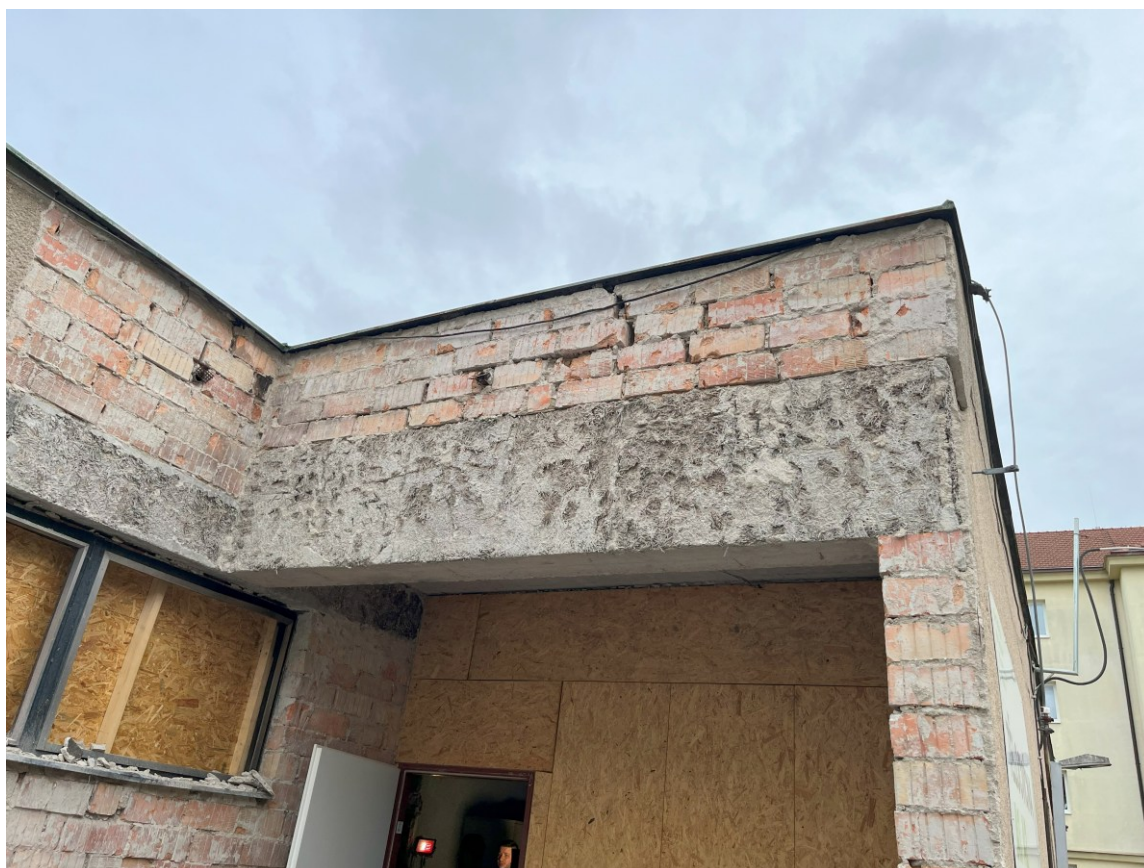
Obr. 3 Pohled na poškozenou atiku ploché střechy
